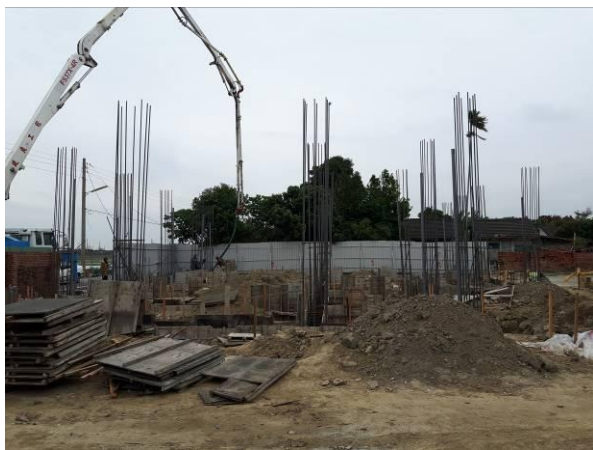
2月5日地樑混凝土澆置
