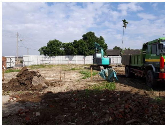
1月16日基地基礎開挖
