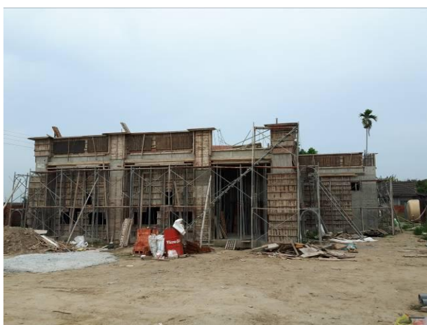
4月20日2樓女兒牆板模組立
