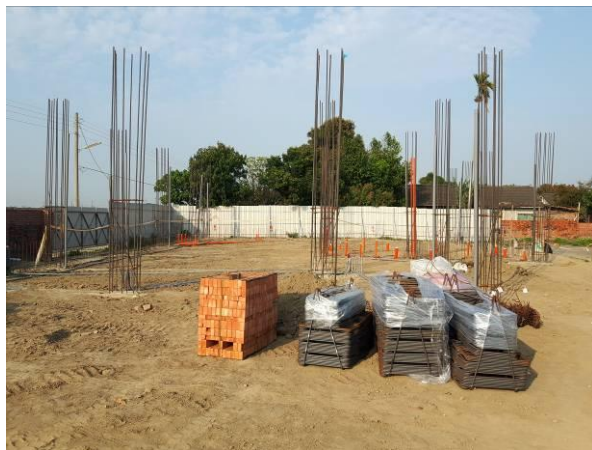
3月2日1樓地坪排水管路裝配
