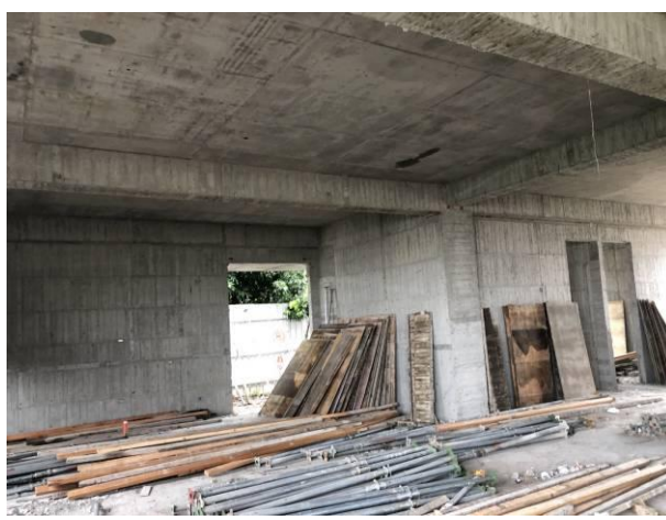
5月9日拆內部模板
